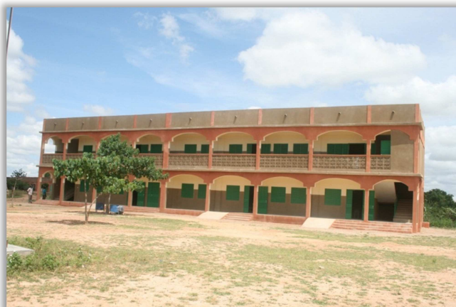
Das neue Primarschulgebäude. Bei der Errichtung des 1. Stockwerks wurden wir vom LED und von Rotary FL unterstützt. Herzlichen Dank!
