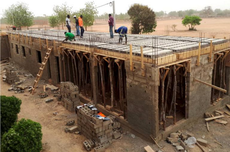
März 2018: Viele der selbsthergestellten Ziegelsteine wurden bereits verarbeitet und der erste Stock steht. Das Dach wird mit Holzpfählen gestützt. Die Bauarbeiten gehen nun rasant voran.
